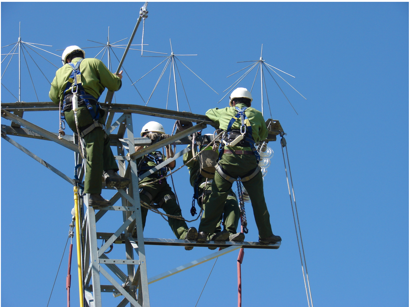
Apoyo con protecciones para pájaros © IBERDROLA, S.A.
