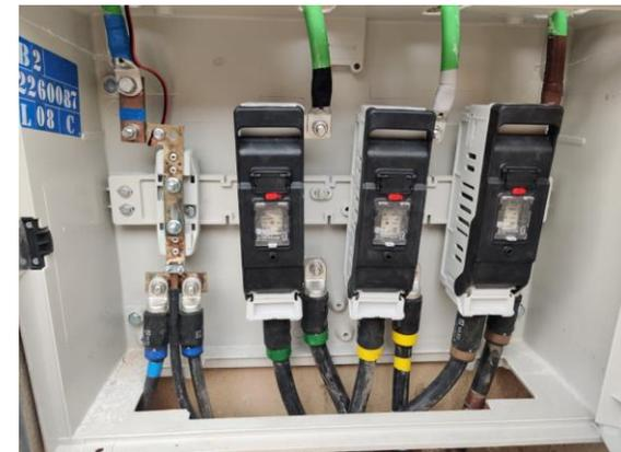
Se ha validado el uso de esta CGP únicamente para su uso en autoconsumo, para permitir la conexión mediante red interior, ya que si el contador de generación se conectará según el esquema 11 sería a través de red. El uso de estas bases de doble conexión no es válido para un suministro de consumo.
